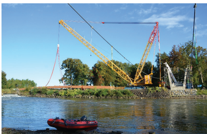
Slika 8. Montaža jeklenih prečnikov, vzdolžnikov in zunanjih opažev.
