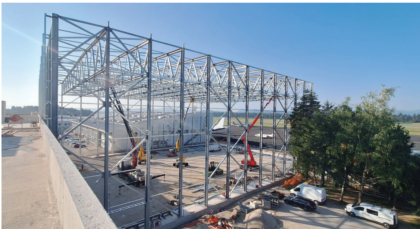
Slika 10. Konstrukcija hangarja (foto: Jernej Nučič).
