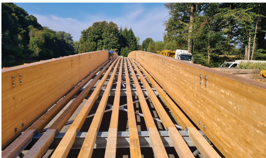
Slika 8. Montaža jeklenih prečnikov, vzdolžnikov in zunanjih opažev.
