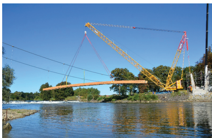
Slika 9. Montaža nosilnih vrvi.
