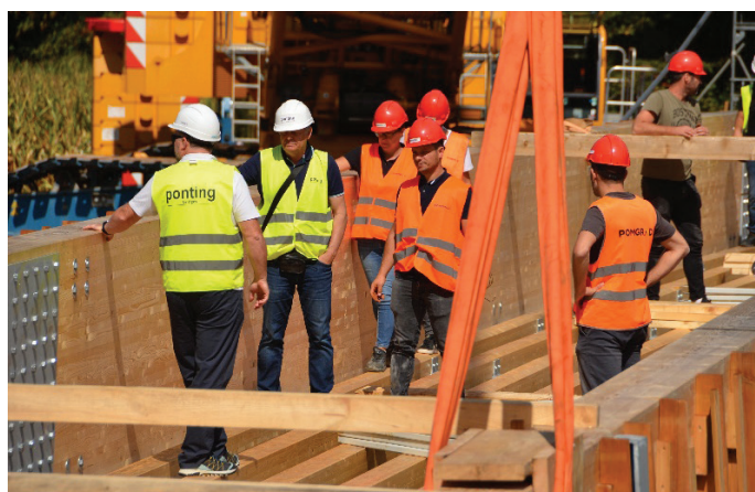
Slika 16. Prvo prečkanje Mure preko novega mostu.
