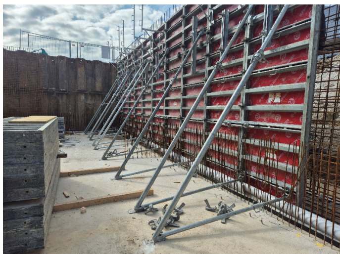
Slika 3. Opaž pasovnega temelja (foto: P. G. Volk).
