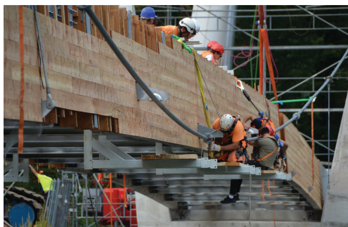
Slika 18. Povezava nosilnih vrvi z mostno konstruk.
