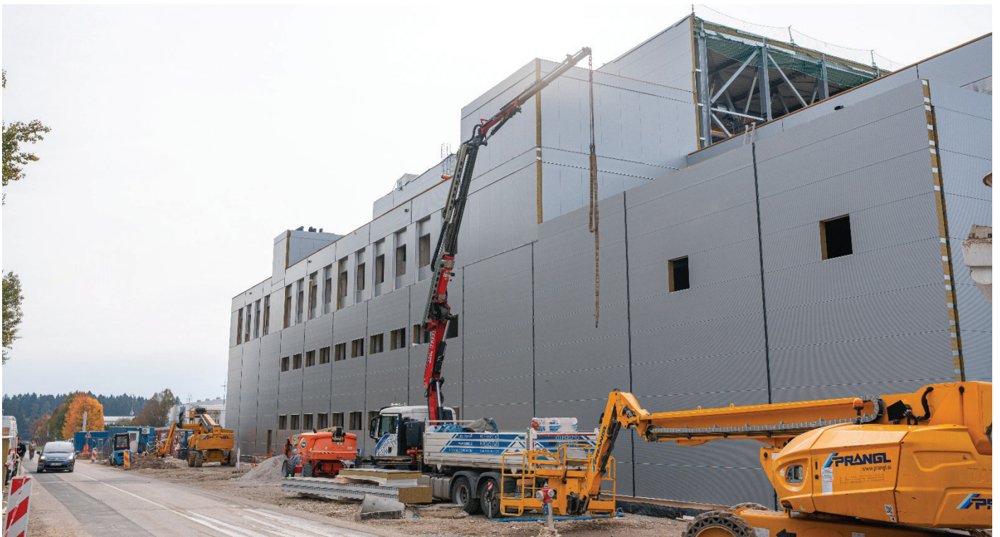
Slika 14. Vgrajevanje fasadnih panelov na severno stran aneksa (foto: Nejc Vurnik).
