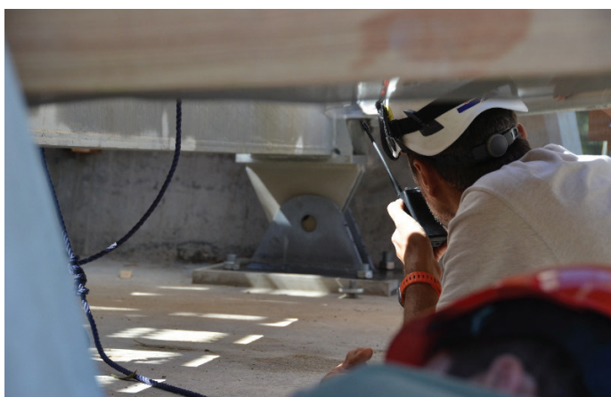
Slika 15. Milimetrska natančnost jeklenega ležišča.
