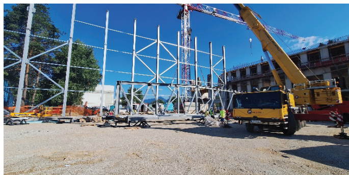
Slika 9. Postavitev prvih stebrov in dvigovanje polovice nosilca (foto: Jernej Nučič).
