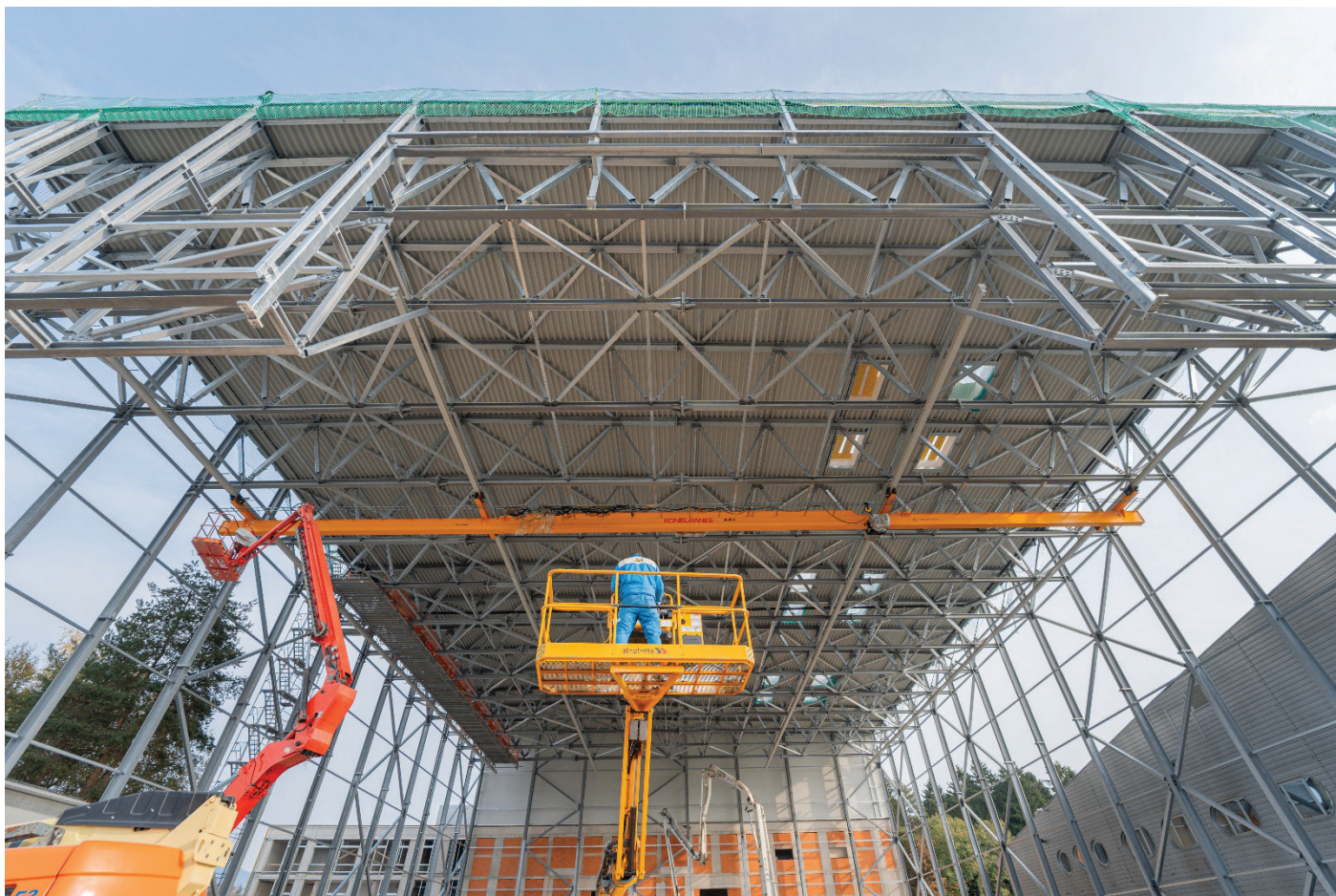
Slika 1. Hangar za vzdrževanje letal (foto: Nejc Vurnik).
