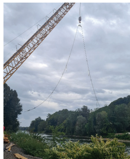
Slika 9. Montaža nosilnih vrvi.
