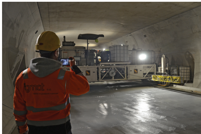
Slika 2. Vgradnja betonskega vozišča v novi cevi predora Karavanke (foto: Združenje za beton Slovenije).
