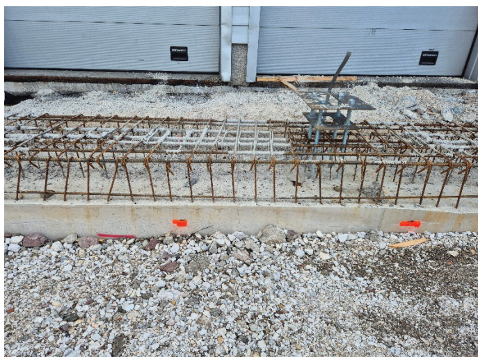
Slika 6. Vgradnja sider za montažo jeklene konstrukcije (foto: Petra Galo Volk).
