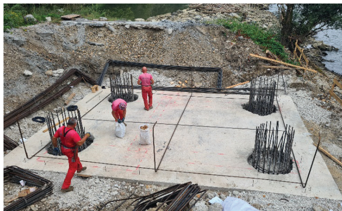
Slika 4. Začetek polaganja armature temeljne plošče.
