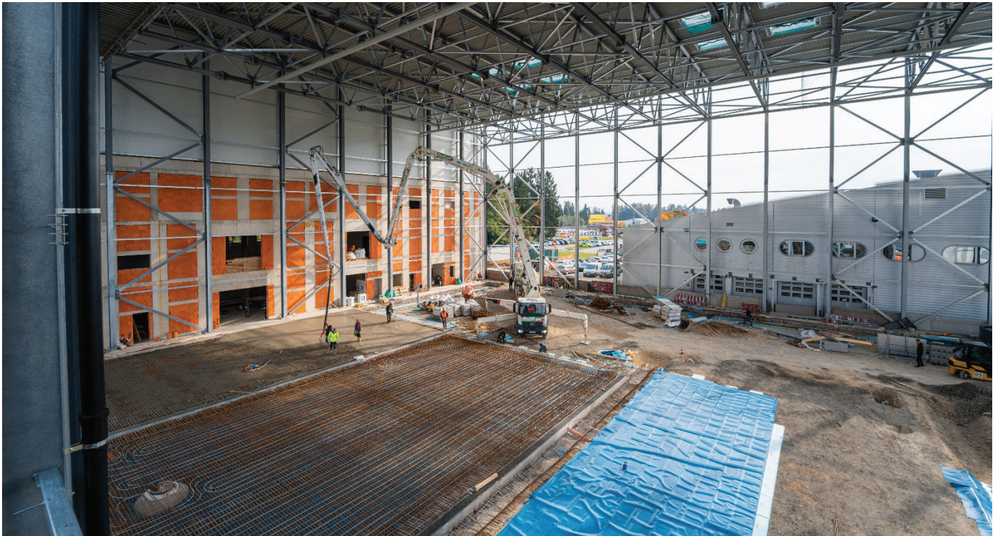
Slika 13. Betoniranje prvega dela temeljne plošče hangarja (foto: Nejc Vurnik).
