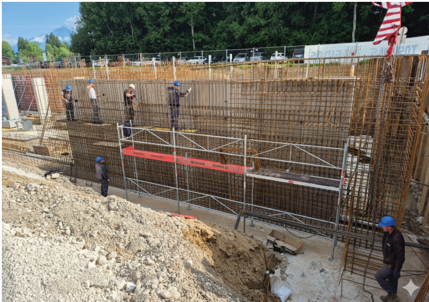
Slika 2. Vežanje armature v prvi kampadi pasovnega temelja (foto: Petra Galo Volk).
