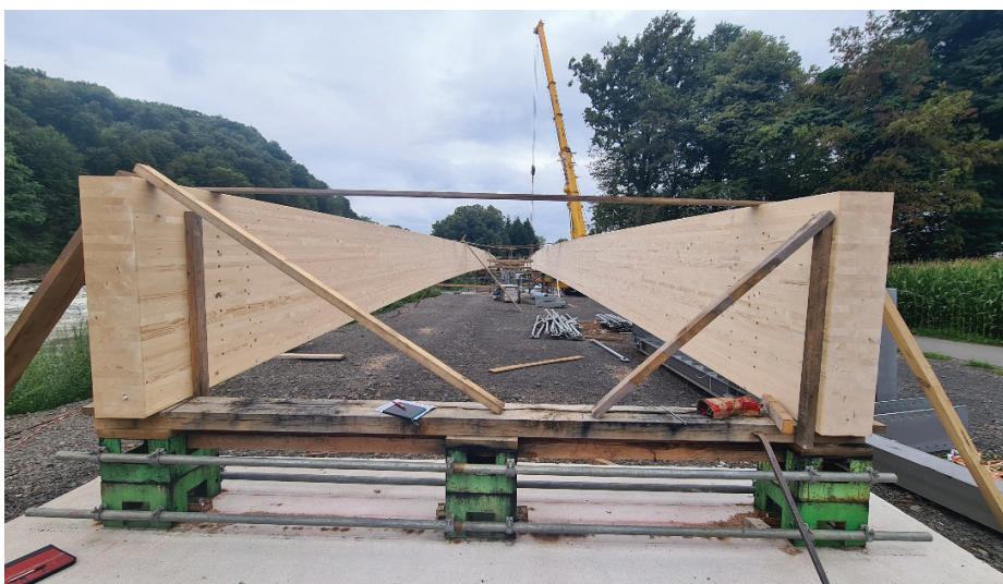
Slika 7. ... montaža lesenih nosilcev na gradbišču (avgust 2025).
