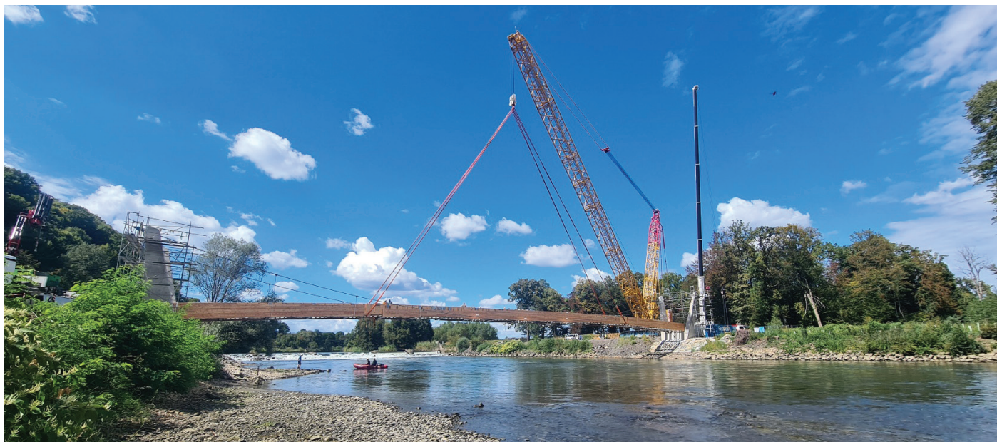
Slika 14. Most prvič v svoji končni poziciji ... še vedno ga drži žerjav (31. 8. 2025).
