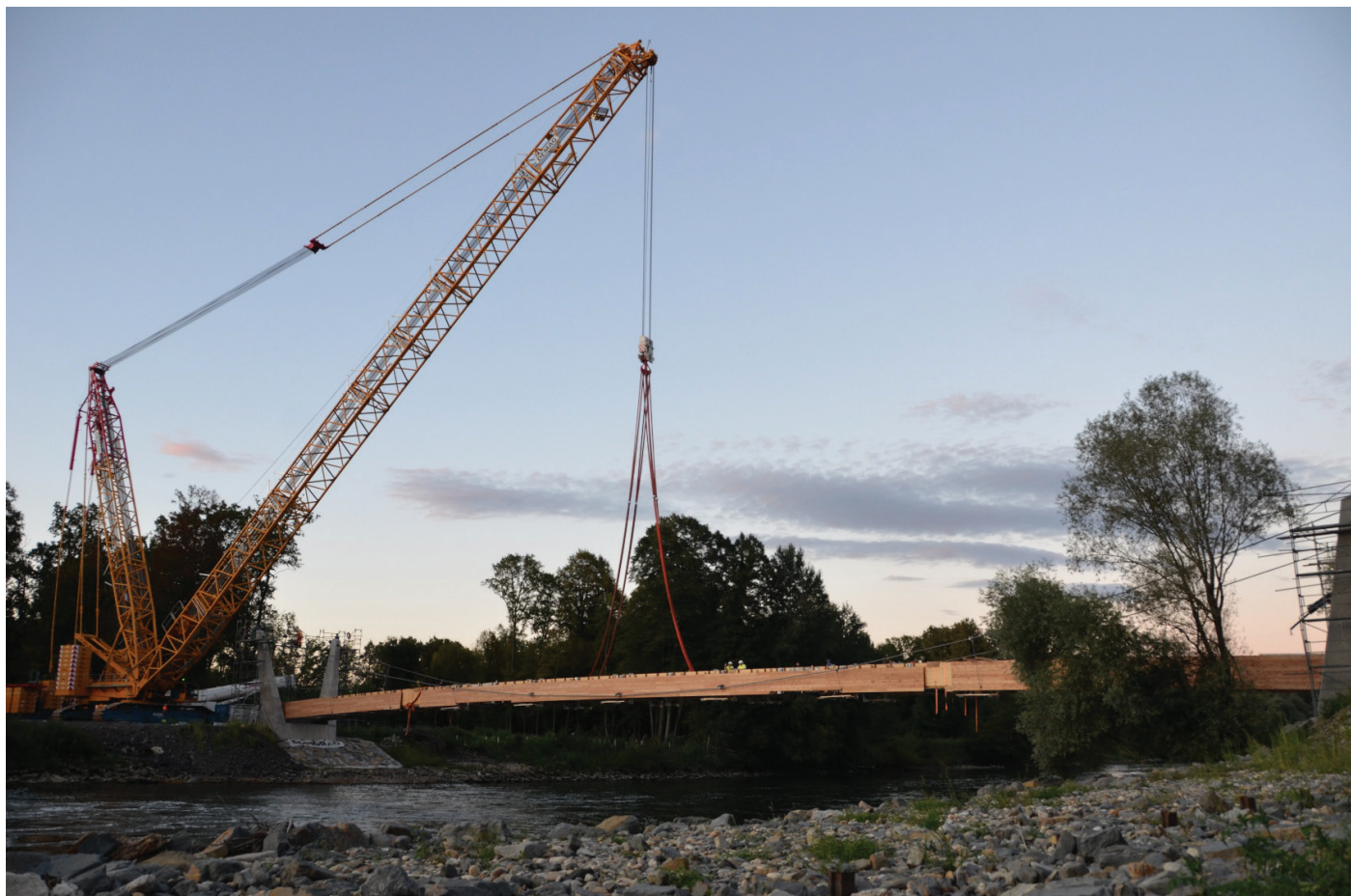
Slika 19. Popuščanje žerjava – montaža mostu je končana (31. 8. 2025).
