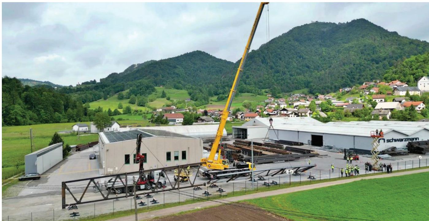
Slika 12. Tesni dvig nosilca (foto: arhiv Schwarzmann).
