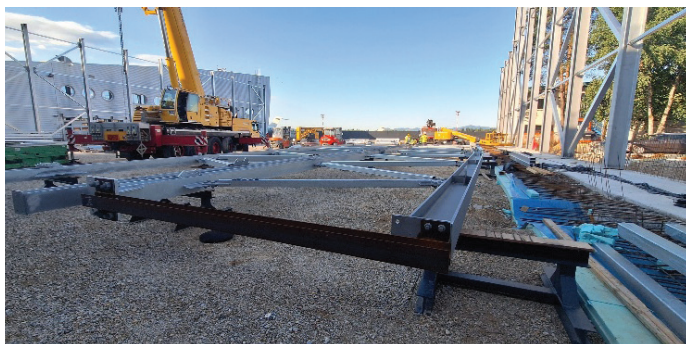
Slika 8. Sestavljanje jeklenega nosilca na tleh (foto: Jernej Nučič).
