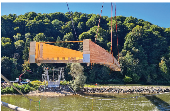
Slike 10, 11, 12, 13. Dvig in montaža mostne konstrukcije (31. 8. 2025).
