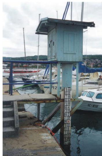
Slika 1: Stari mareograf v Kopru, ki je imel tudi razdelbo, kjer je bilo čitanje ročno
