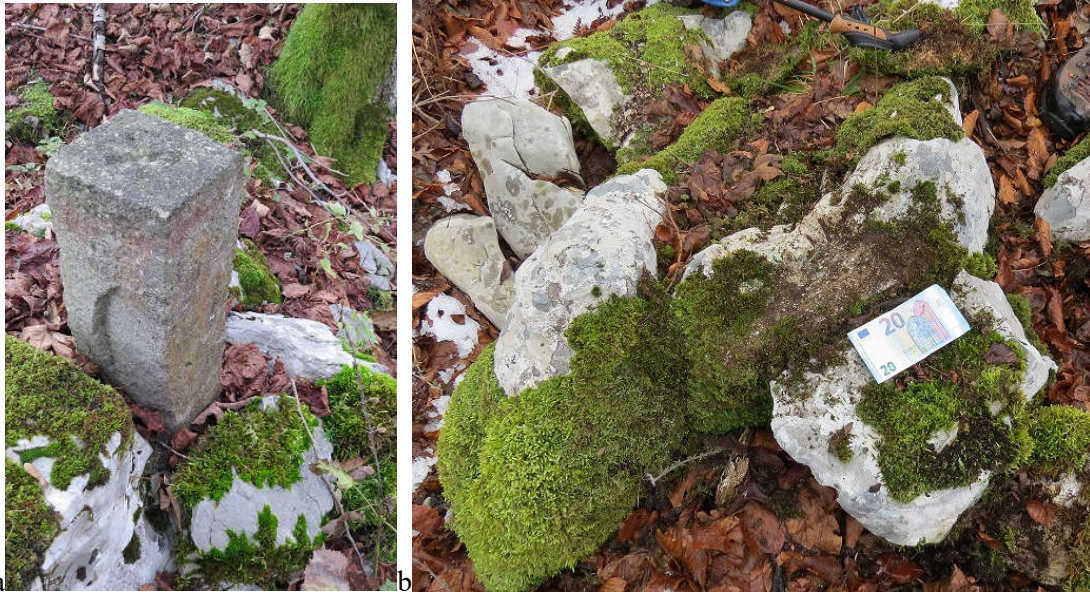
Slika 4: Dva zanimiva primera geodetskih znamenj iz območja Menišije: a) Raskovec, 241. III. red, trig. okraj 10, b) Lom, 54. IV. red, trig. okraj 16 – na sredini skale kjer smo jo očistili mahu se nahaja železni žebliček (foto: M. Triglav Čekada, 2021).
