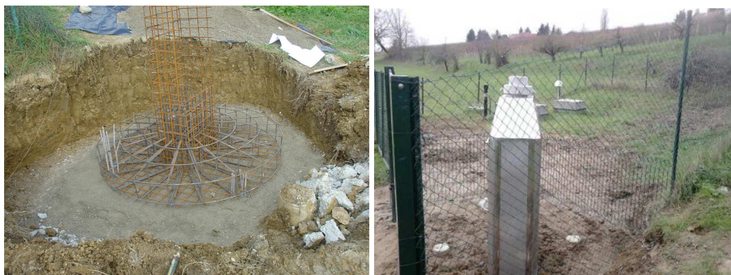
Slika 6 - Armatura krožnega temelja in stebra (levo) ter pogled na dokončno zgrajen steber z GNSS točko in tremi nivelmanskimi točkami ter potresno opazovalnico KOGS (vir: GURS)
