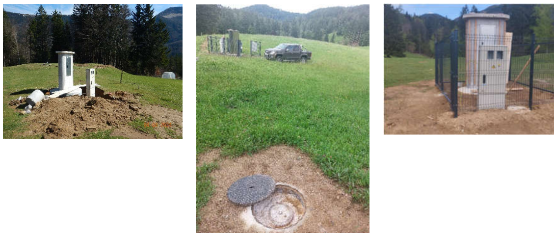
Slika 5: Utrinki z gradnje, točka Javorniški Rovt
