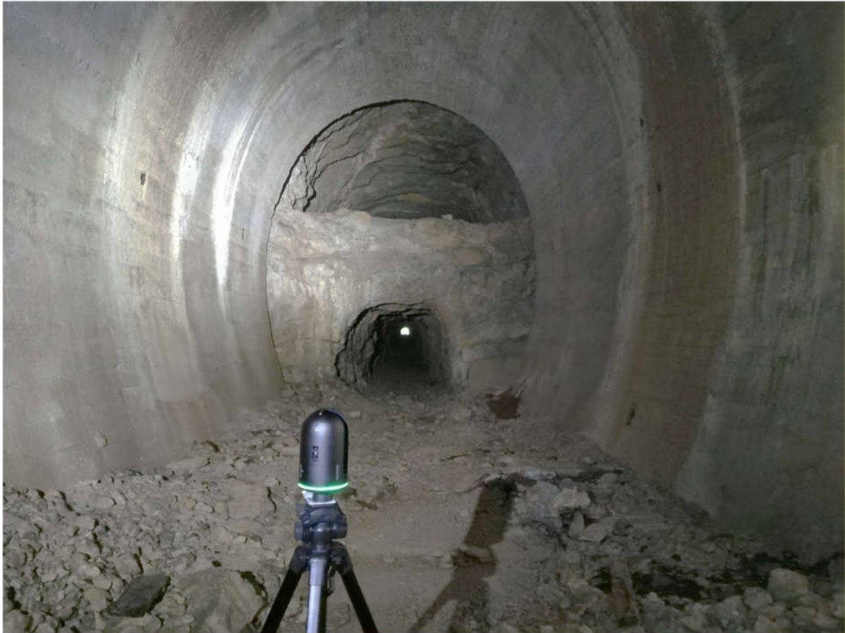
Slika 3: Severni del predora, kjer je obok predora v celoti betoniran, s pogledom proti južnemu vhodu, kjer vidimo izkopano kaloto.
