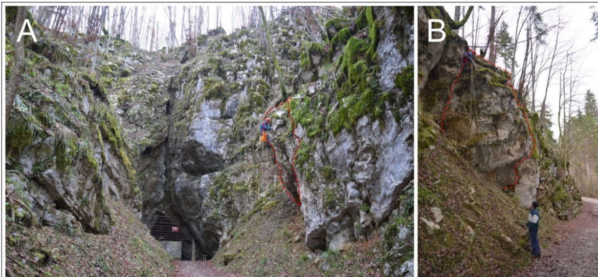
Slika 1 – Obseg potencialno nestabilne skalne gmote iz smeri proti (A) in od vhoda v Križno jamo (B). Obseg potencialno nestabilnega dela zahodne stene je označen z rdečo prekinjeno črto.
