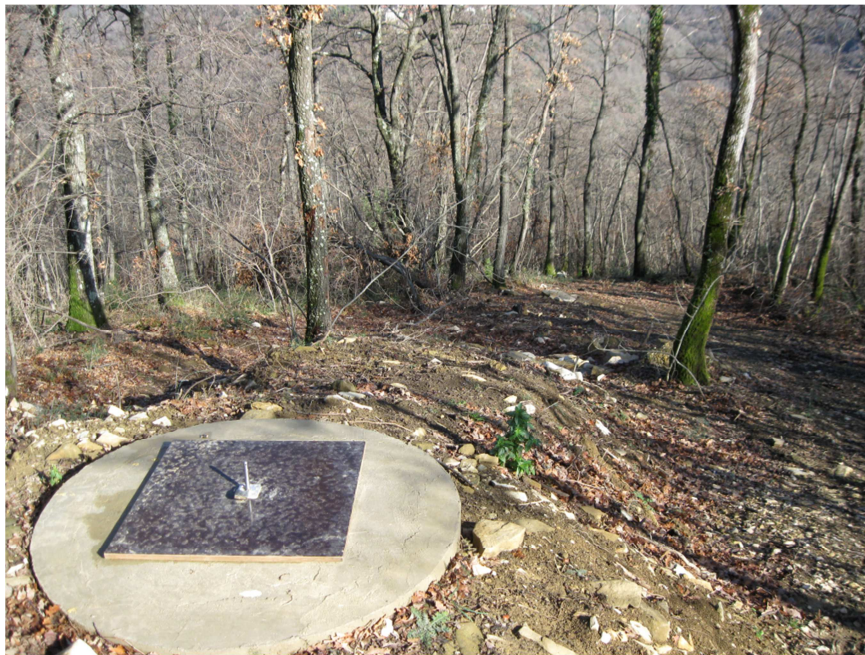
Slika 1 – Glavni jašek na geomagnetnem observatoriju PIA (Piran, Slovenija) po končani 1. fazi njegove gradnje v januarju 2015.
