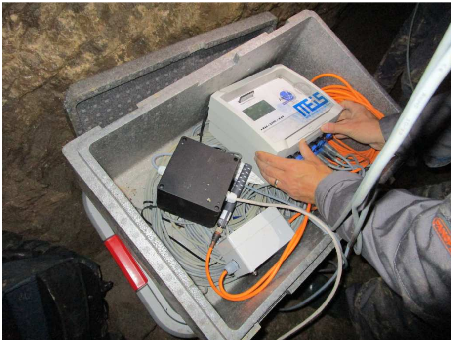
Slika 5: Slike jamske avtomatske merilne postaje za meritve na lokaciji »Tartar«
