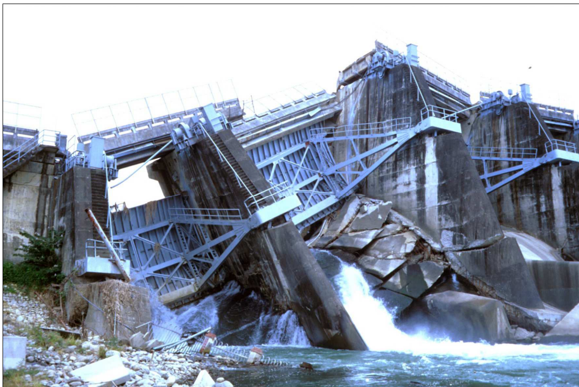
Slika 1 - Ob potresu na Tajvanu leta 1999 se je podrla na prelomu zgrajena pregrada Ši-Gang (foto: R. Vidrih).
