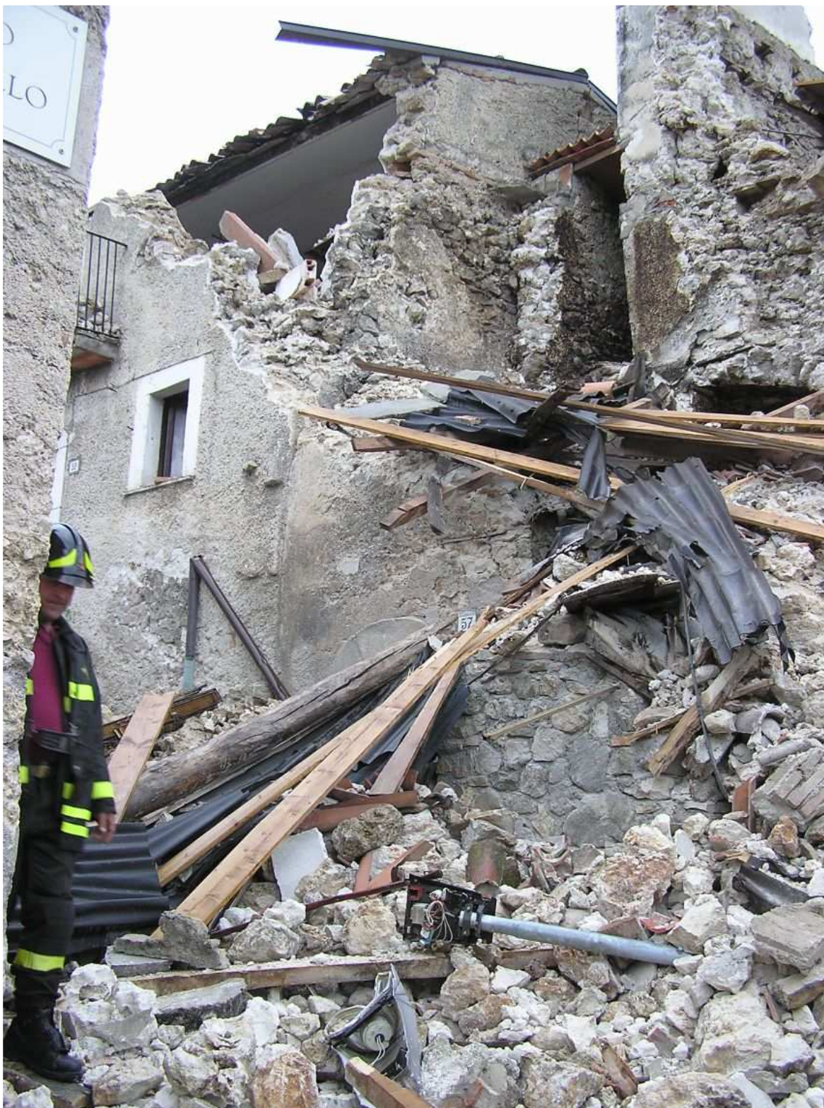
Slika 5. Porušeno središče vasi Camarda. Material hiš je bil mešan (obdelan in neobdelan kamen, opeka), stropi leseni, malta pa slaba. (foto: I. Cecić)
