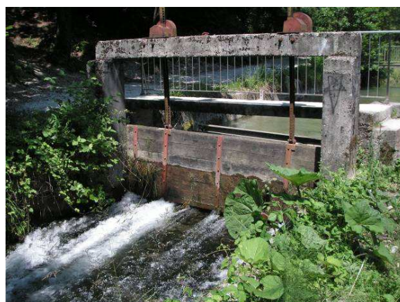
Slika 3 - Preliv Homškega jez z zapornico za talni izpust na sredini v času nizkih vodostajev dne 21. 8. 2009 (levo) in zapornica, ki regulira količino odvzete vode za mlinščico (desno) (foto: Bogataj, 2009).
