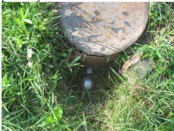
Slika 1 - Stabilizacija reperja R100
