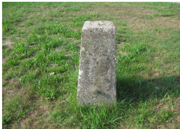
Slika 2 - Stabilizacija reperja RIV
