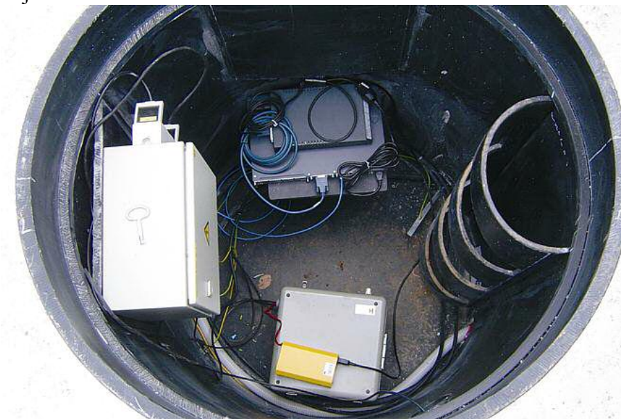
Slika 5 -V pomožnem jašku je nameščena komunikacijske oprema in brezprekinitveno napajanje.
