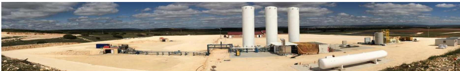
Hontomin, Španija: Pričetek vtiskavanja CO 2 v jurske karbonate 1500 m globoko
