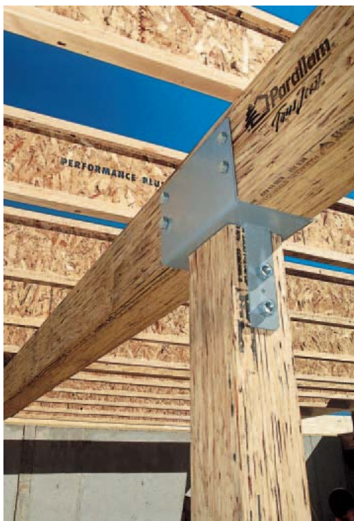
Primeri nosilnih elementov izdelanih iz zlepljenih na pasove razrezanih furnirjev (Parallel strand lumber – PSL), Na levi sliki so lepljeni »I« nosilci izdelani iz lepljenih pasnic in stojine iz OSB plošč.
