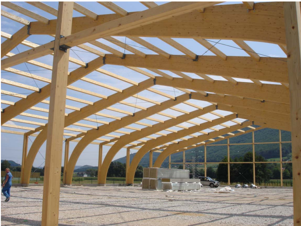
Svobodno oblikovanje – lamelirane lepljene lesene nosilne konstrukcije (izvedba podjetje Hoja d.d., Škofljica)
