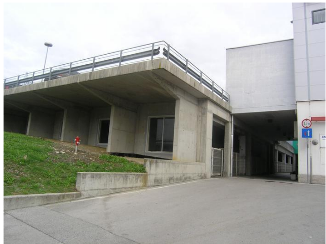
Slika 10 Armiranobetonski industrijski objekt.
