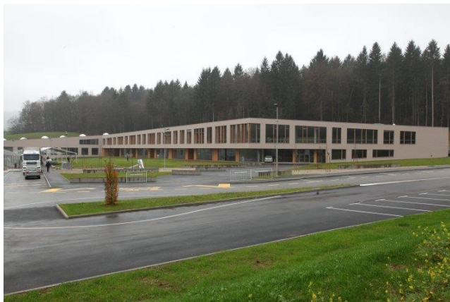
Slika 11 Armiranobetonski šolski objekt.
