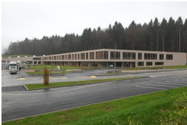
Slika 11 Armiranobetonski šolski objekt.
