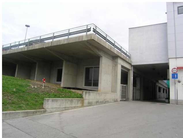
Slika 10 Armiranobetonski industrijski objekt.
