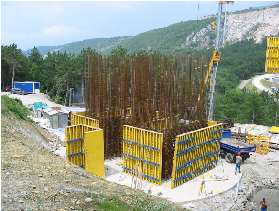
Slika 10 Opaž betonskega stebra, ki nosi viadukt Črni Kal.
